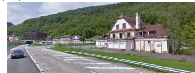
Entrée de ville Ste Marie : Les halles, un nœud routier et des bâtiments à l'abandon : porte d'entrée du territoire peu qualitative
